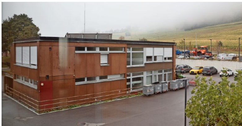
Am Morgen liegt das Schulhaus Looren schon mal im Dunst. Von Vapes kommt dieser aber zum Glück nicht.
